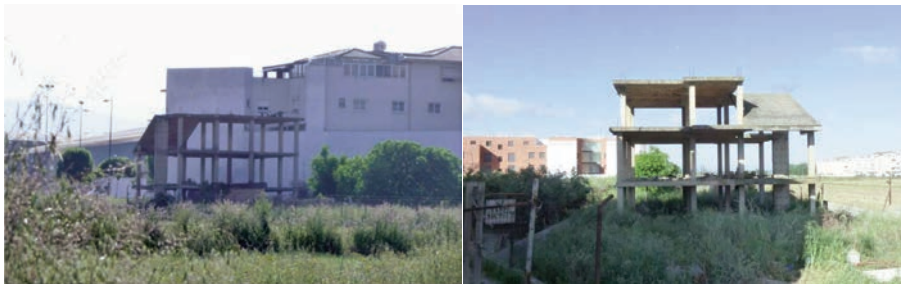
Estructura al noreste del ámbito
