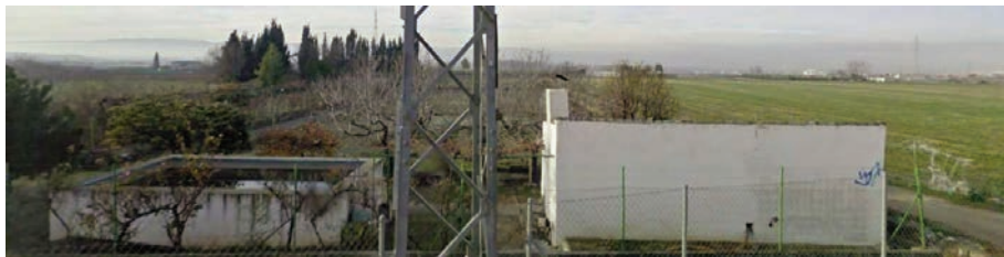
Edificaciones existentes borde Oeste del ámbito
